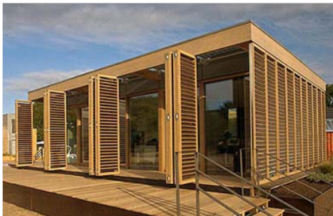
Bild aus dem Beitrag " Solarhaus der TU Darmstadt gewinnt Solar Decathlon 2007 in Washington " vom 28.10.2007
