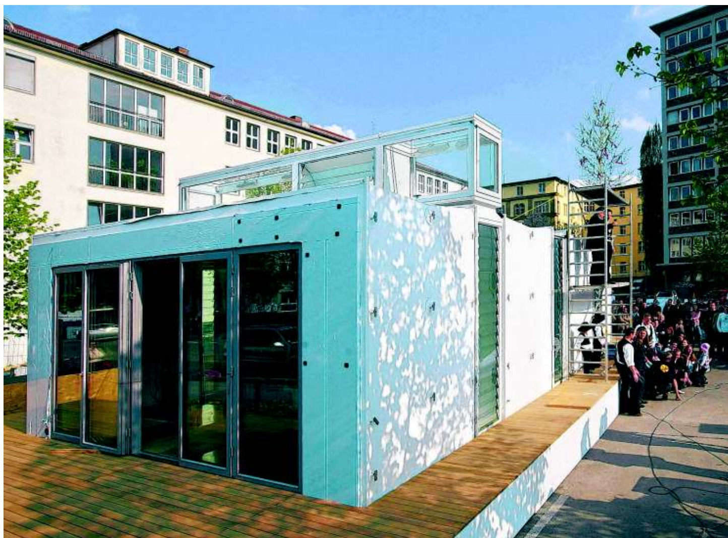
Der Rohbau steht: Das technische Herzstück des „Home plus“-Hauses ist der gläserne Aufsatz mit den Belüftungslamellen. Foto: Zweygarth
