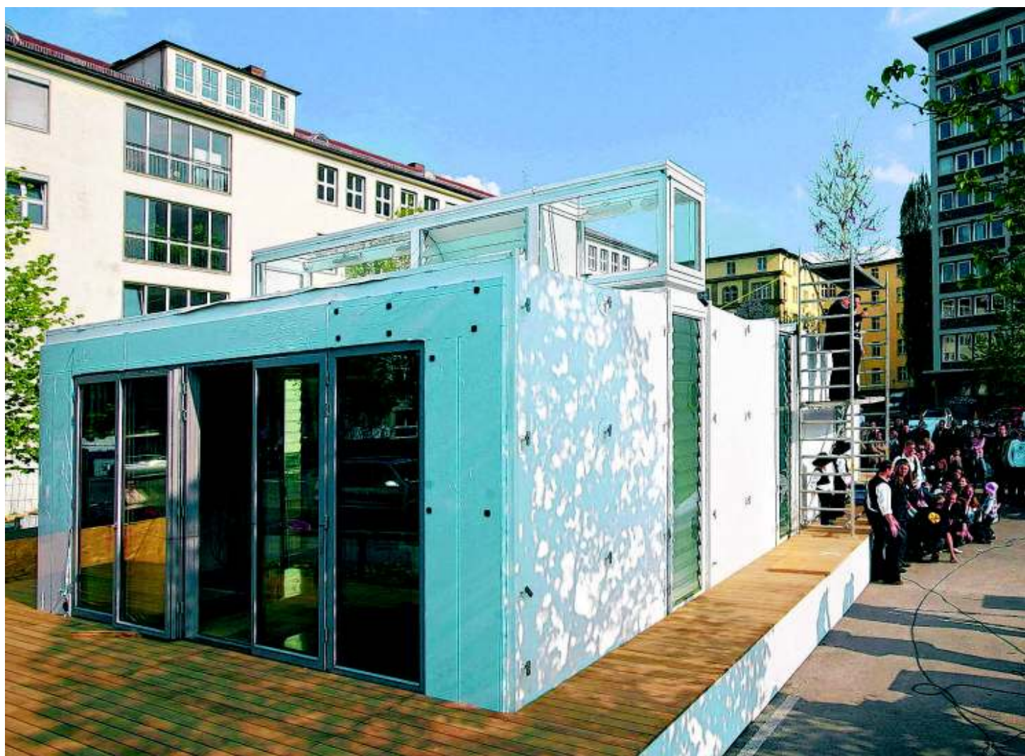
Der Rohbau steht: Das technische Herzstück des „Home plus“-Hauses ist der gläserne Aufsatz mit den Belüftungslamellen. Foto: Zweygarrth
