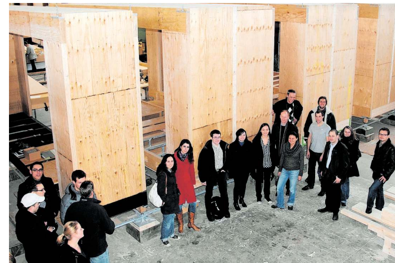
Die Holzarbeiten für das Solarhaus haben bereits begonnen. Die Studierenden begutachten nun den Baufortschritt. Foto: Hochschule für Technik
