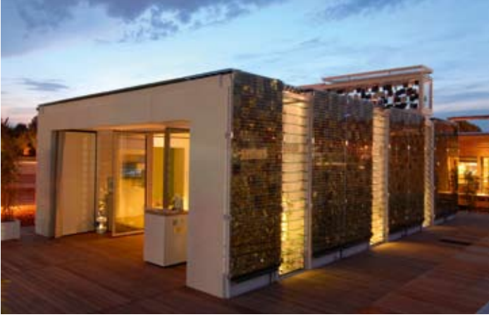
Das Plus-Energiehaus „home+“ soll als lebendiges Labor für die Forschung und Lehre genutzt werden
